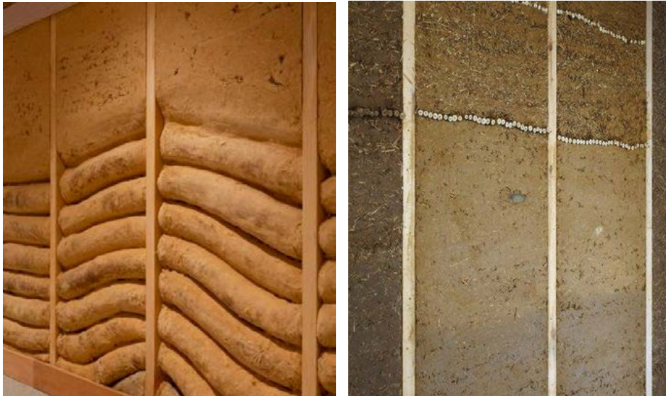
Projet de construction avec de la bauge et du torchis © C. & S. Dugelay
