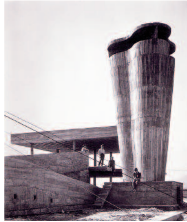
Le Corbusier, toiture de l'unité d'habitation en chantier. Béton
